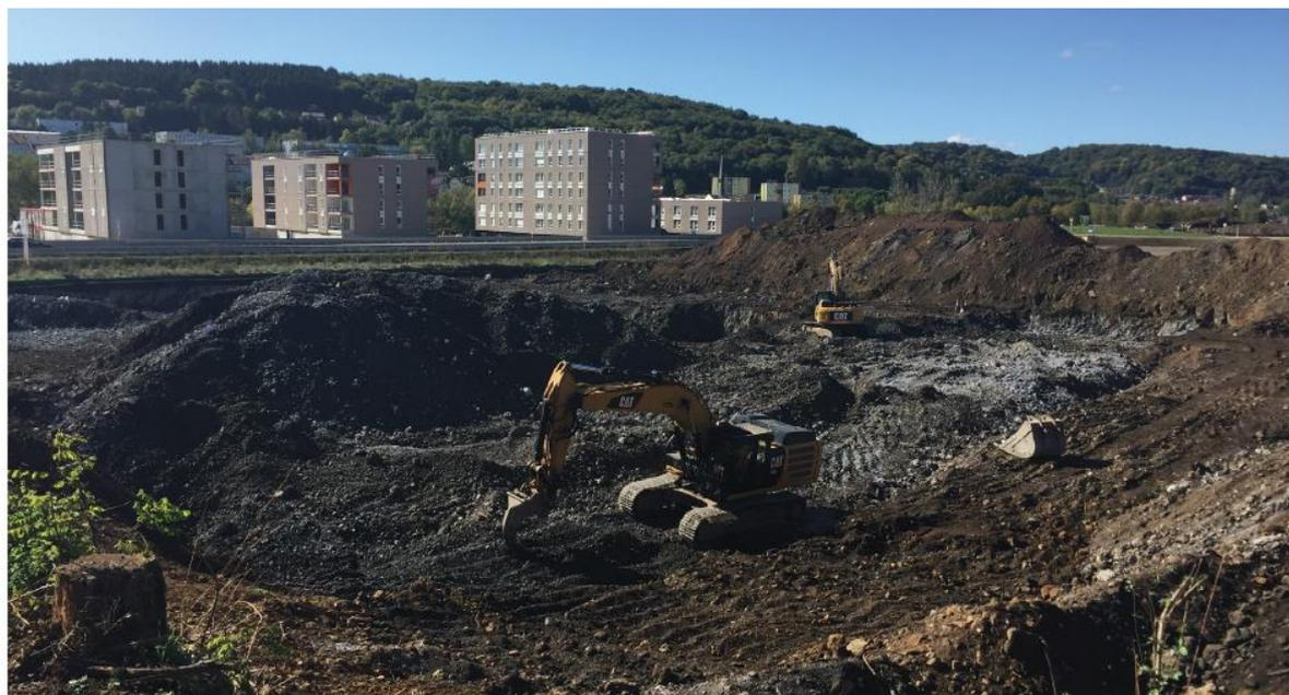
*L'exploitation du laitier en plateforme haute*
